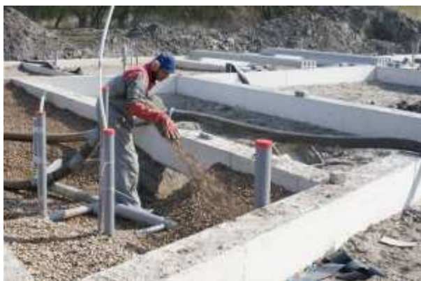
Figura 1: Aplicarea cochiliilor pentru izolație
