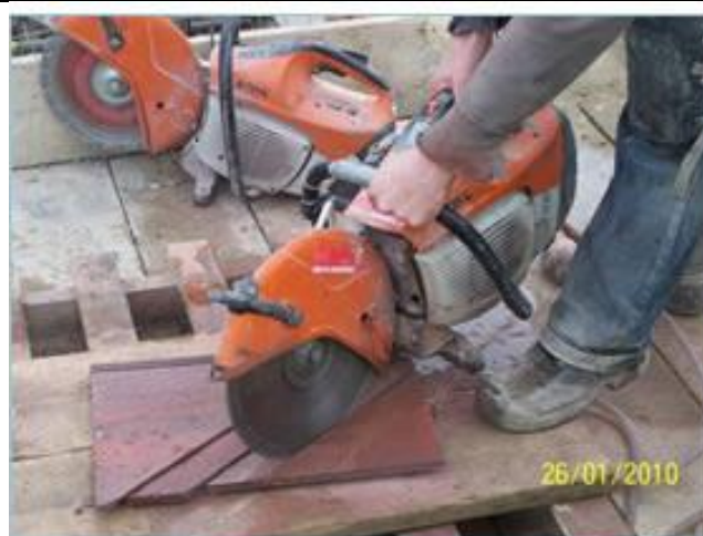
Bună practică - tăierea țiglelor cu mașina de tăiat țigle (National Federation of Roofing Contractors Ltd, Regatul Unit)
