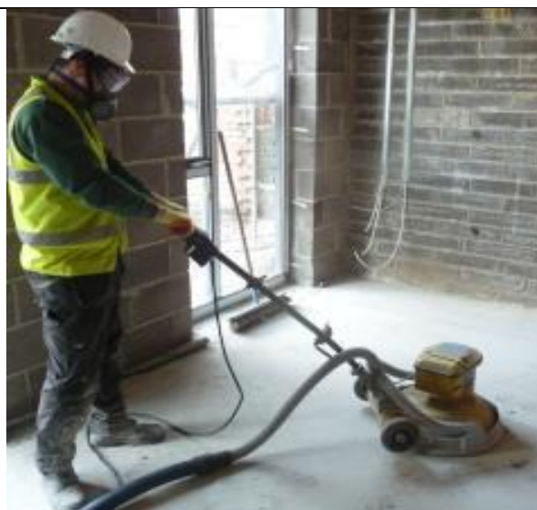
Bună practică - șlefuirea pardoselilor de beton cu unelte dotate cu echipamente de îndepărtare a prafului integrată (HSE, Regatul Unit)
