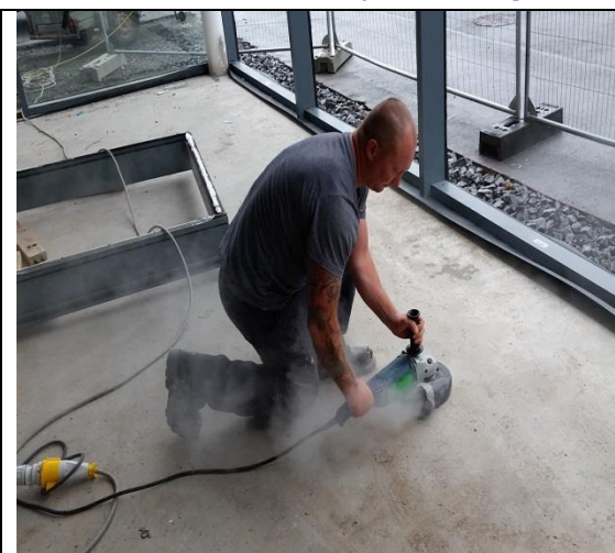
Practică defectuoasă - utilizarea unei mașini de scarificat operată manual dotată cu echipament de îndepărtare a prafului (HSA, Irlanda)
