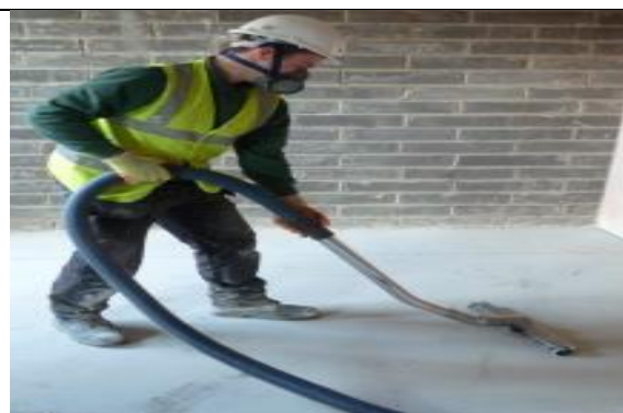
Bună practică - Îndepărtarea prafului utilizând aspirarea cu filtru cu eficiență mare (HSE, Regatul Unit)
